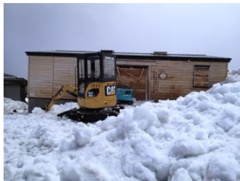
富士山頂公衆トイレの様子 (撮影: 橋本)
